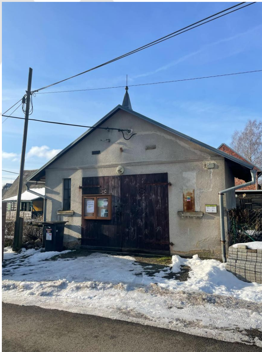
Obr. č. 1.4.4: hasičská zbrojnice
